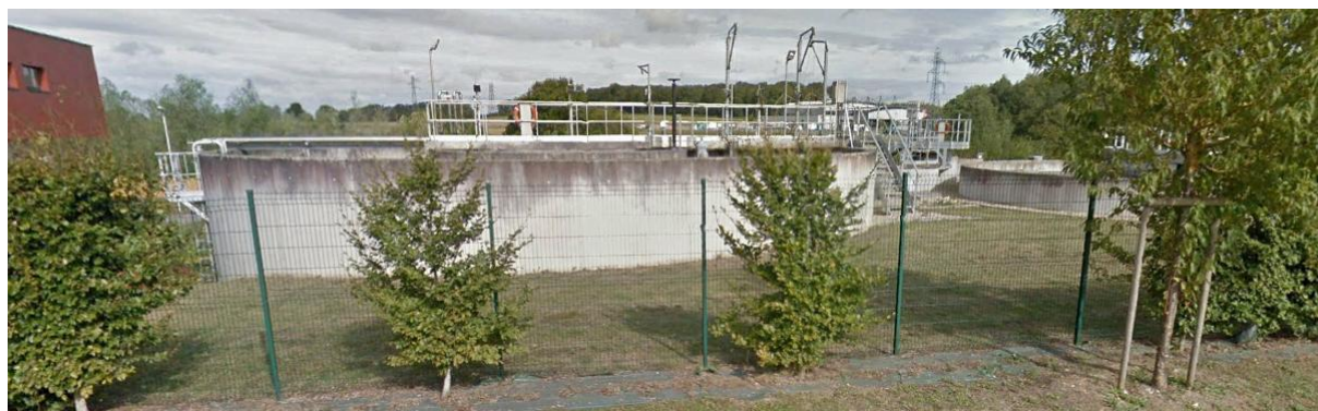
Figure 48 : Station d'épuration d'Heudebouville
